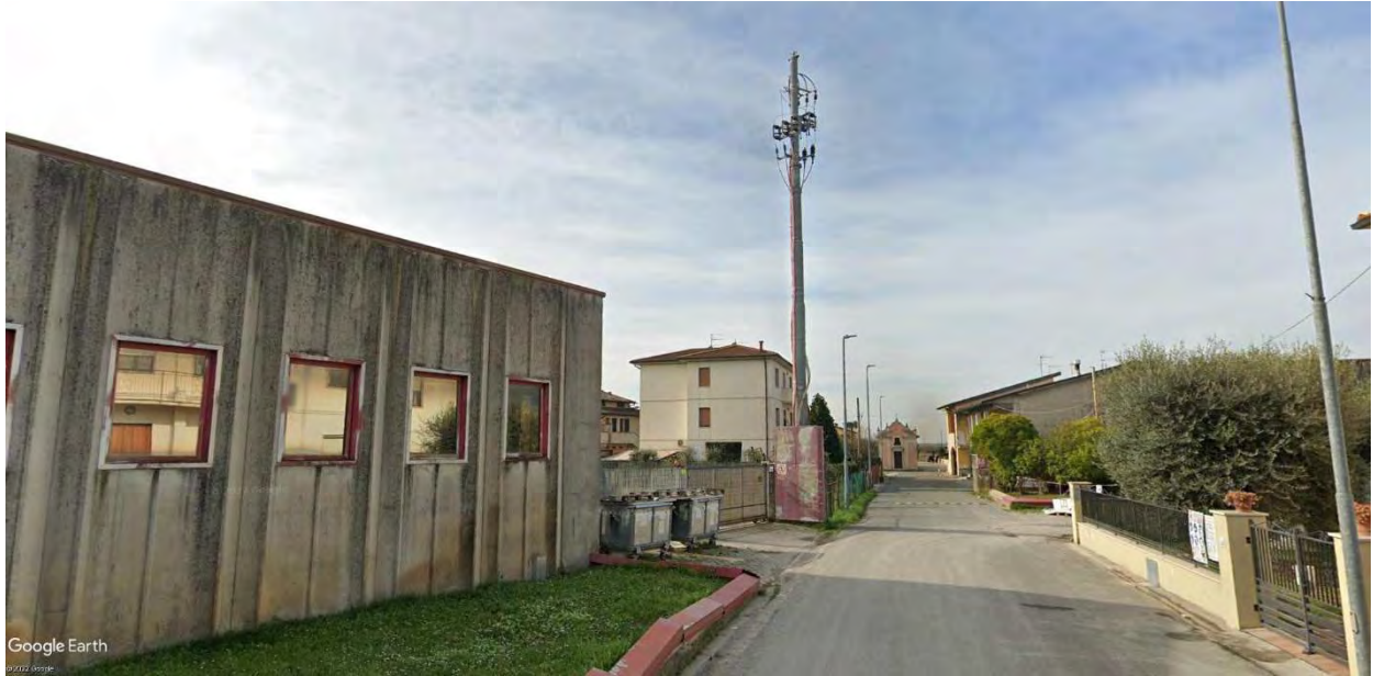
F5 - Palo per linea media tensione esistente da rimuovere
