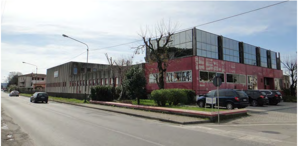
F1 – Vista nord-est, da SS439. Fronte principale.
